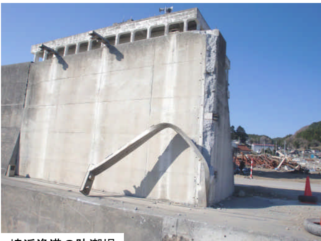
崎浜漁港の防潮堤
